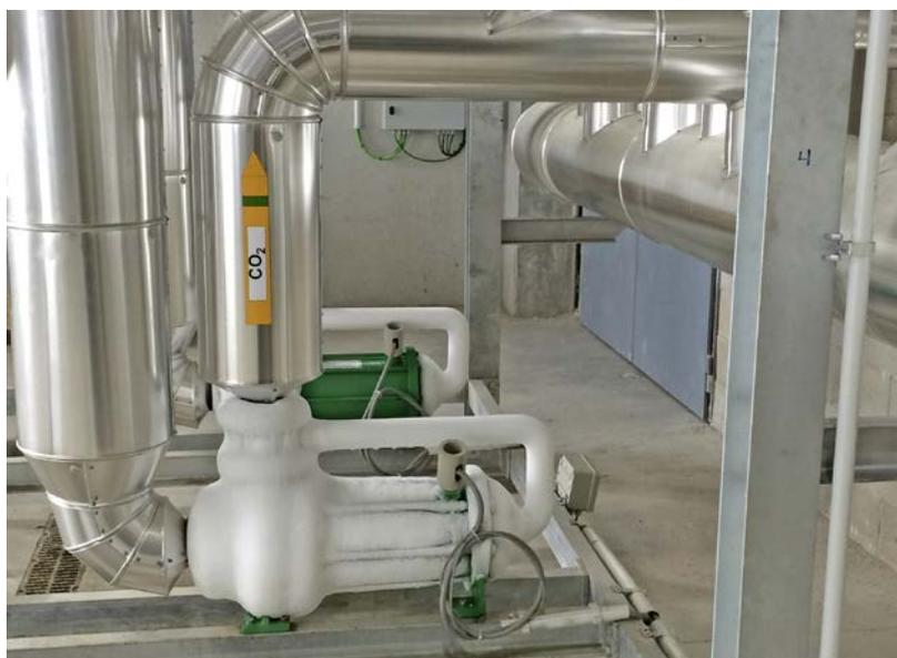
Ansicht einer  $\text{CO}_2$ -Kältemittelpumpe
